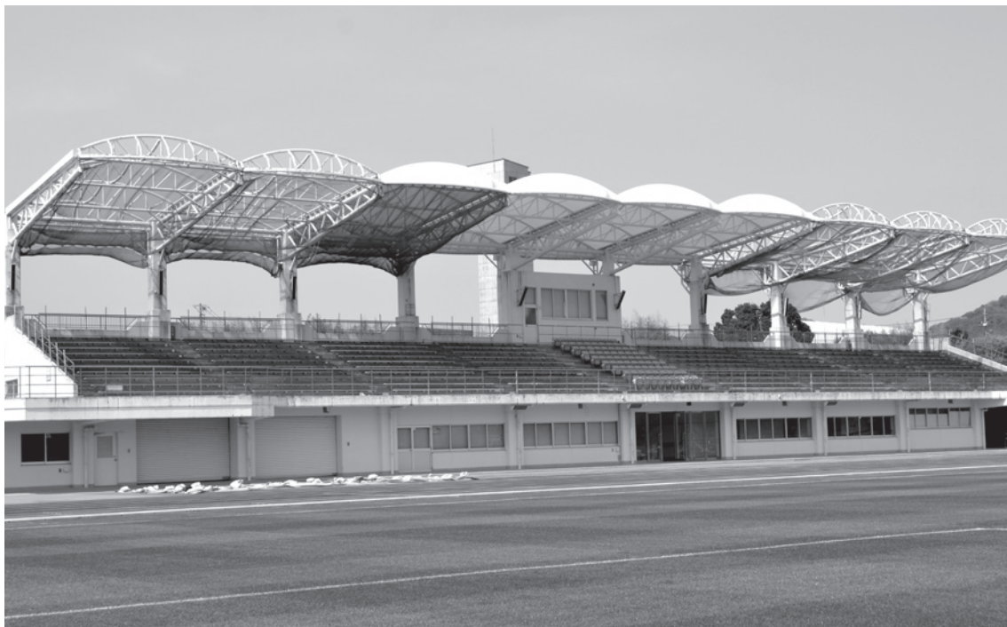
現在の陸上競技場観客席、屋根の状況
