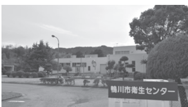
老朽化の進む衛生センター施設
