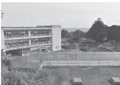
閉園後の太海フラワー磯釣りセンター
