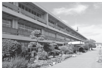
築50年を経過した鴨川小学校校舎
