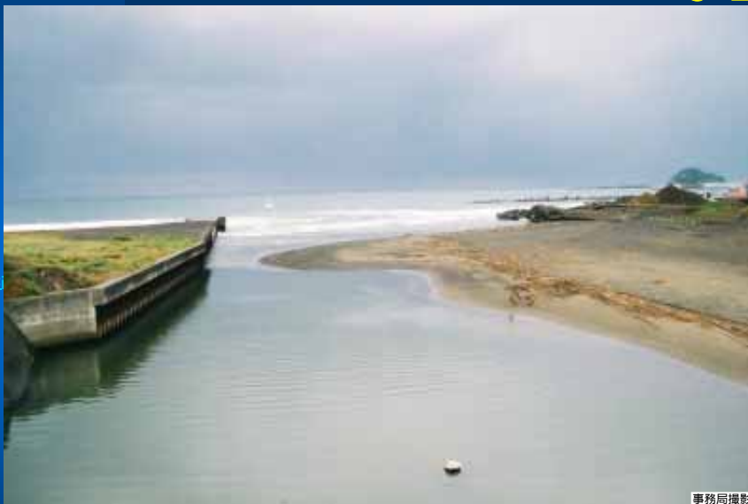
写真-20 待崎川河口の導流堤内側の右岸から左岸に向けて伸びた砂州 2004/3/7
