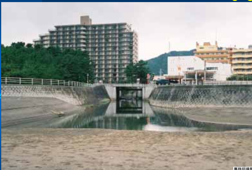
写真-35 夜長川河口:波によって押し込まれた土砂が堆積して 前面が閉塞した河口
