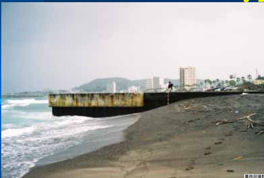
写真-22 待崎川河口左岸導流堤を北側から望む: 粒径の粗い砂礫が混じる急勾配の前浜(比高の高いバーム)
