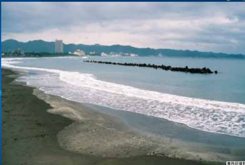
写真 - 10 前原海岸南端の離岸堤
