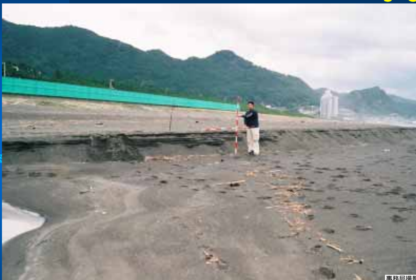
写真-38 同上:河川流の出口の左岸に見られた河岸侵食
