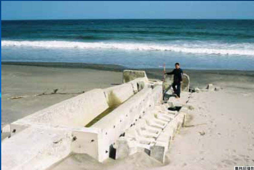
写真-26 同上:7カ月前(2003年4月19日撮影)には埋没してなかった同じ排水路 2004/3/7
