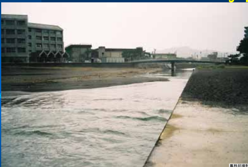
写真 - 19 待崎川河口から上流を望む：海浜の砂礫が波で押し込まれて 河道右岸に堆積してきた砂州
