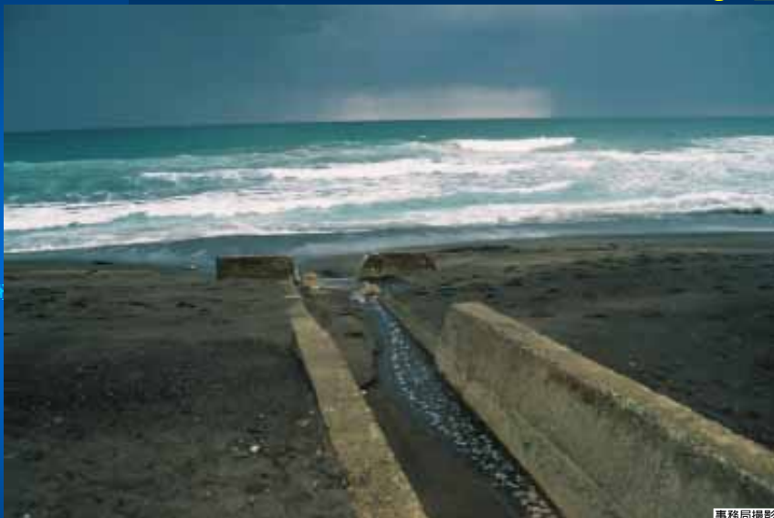
写真-25 待崎川河口～鴨川シーワールド間で見られた堆砂によって埋没した排水路
