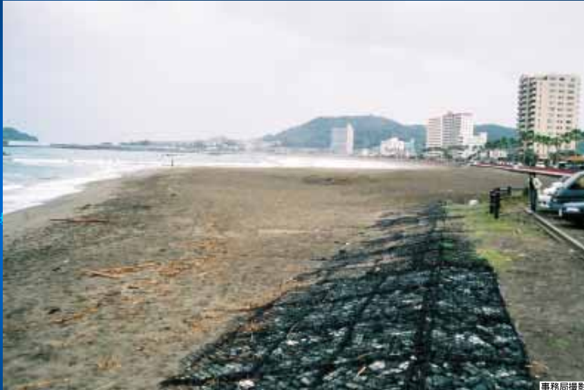
写真-16 南側から3基目の離岸堤背後の堆砂により沖に張り出した舌状砂州 2004/3/7 17
