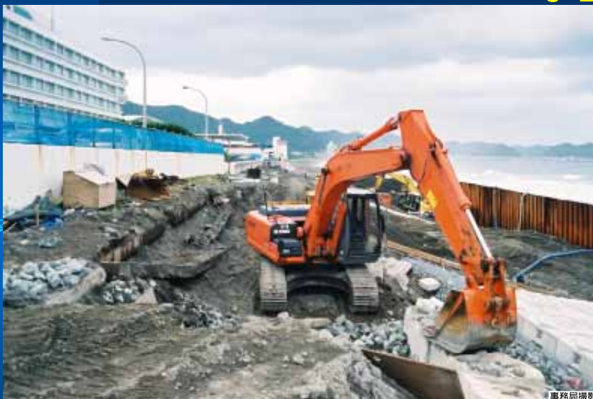
写真-29 鴨川シーワールド前の波によって破壊された護岸の災害復旧工事現場
