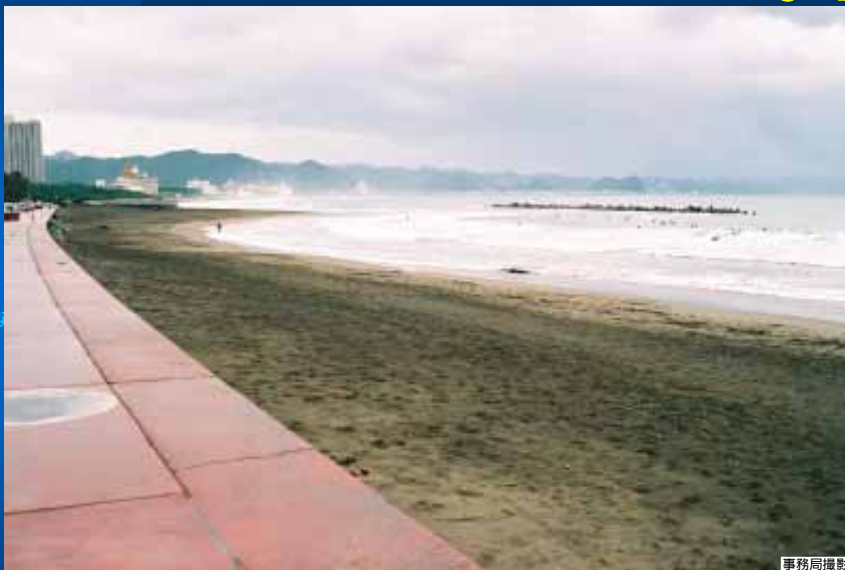
写真 - 14 南側から3基目の離岸堤背後で沖に張り出した汀線(舌状砂州)を望む 2004/3/7
