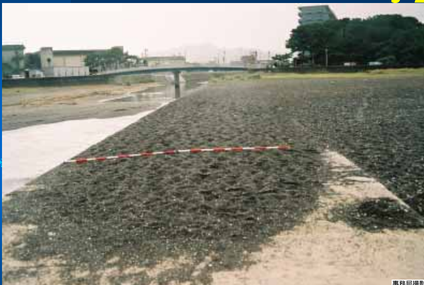
写真-21 待崎川河口左岸導流堤:波によって左岸の海岸から打ち上げられた 砂礫が導流堤天端上を乗り越えて河道に流入した痕跡 2004/3/7
