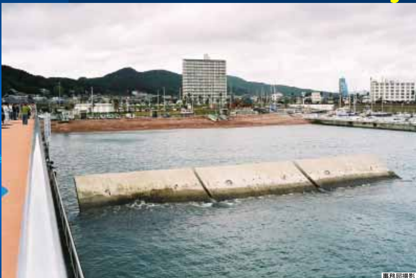
写真-7 鴨川漁港前原地区の小型漁船用舟揚げ斜路を港口から望む (手前は斜板型防波堤)
