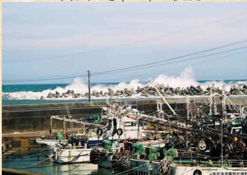
航路防波堤の沈下
