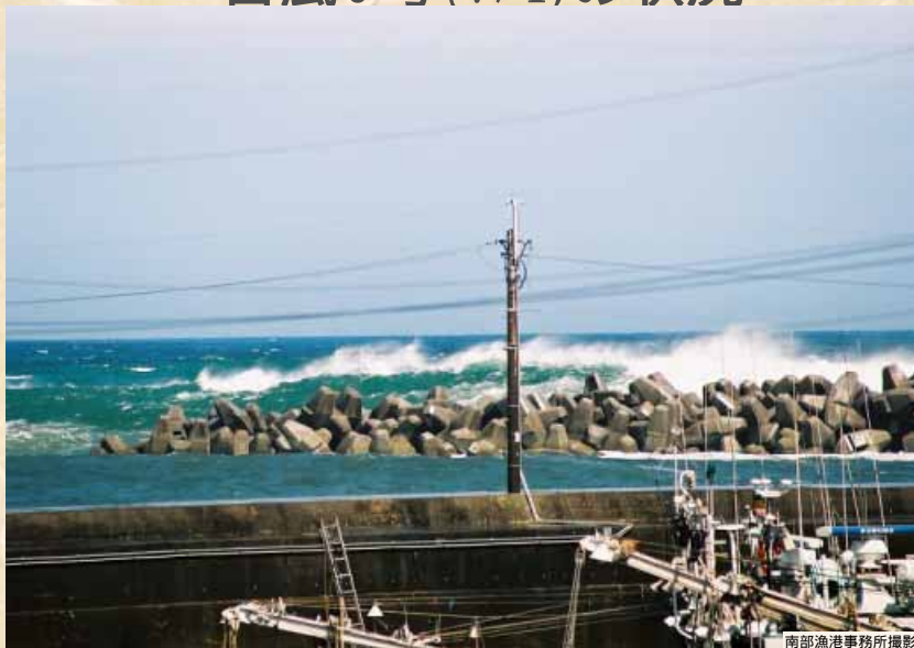
航路防波堤の沈下
