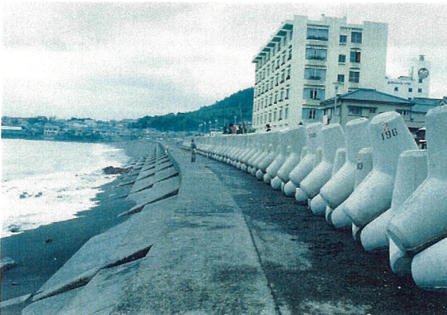
← ＜前原海岸の傾斜護岸（2割勾配）＞
