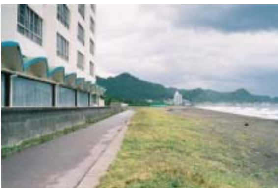
写真-6 鴨川ロイヤルホテル地先(平成15年撮影)
