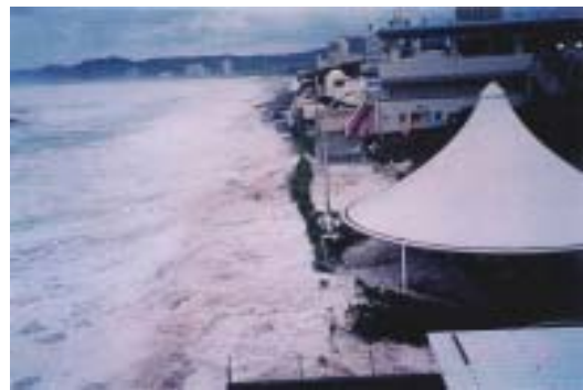
写真-1 背後民間施設への浸水状況(平成9年撮影)
