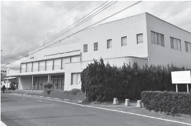
閉館して3年が経過している旧市民会館
