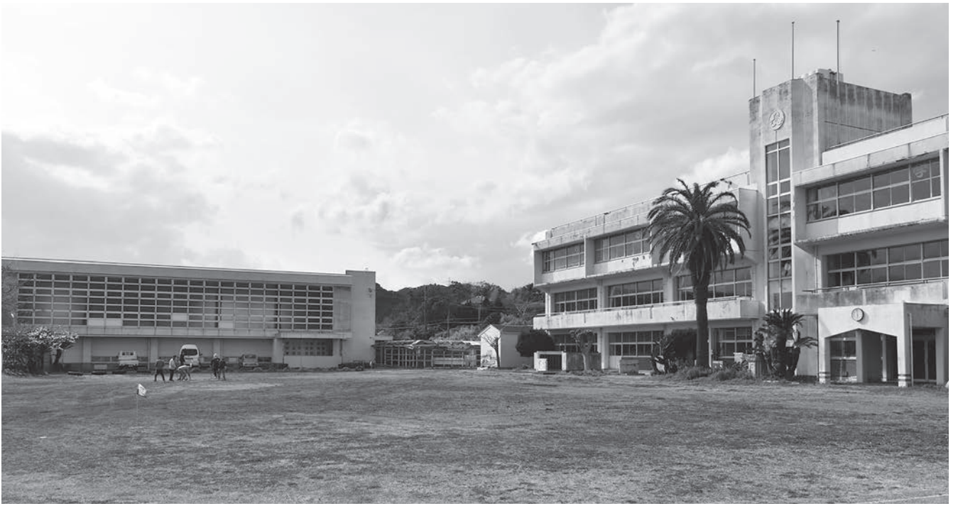
旧江見小学校の現況
