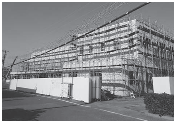
足場が組まれ解体が進む、旧市民会館
