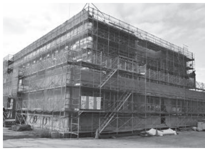
令和3年2月の開院に向けて工事が進む
