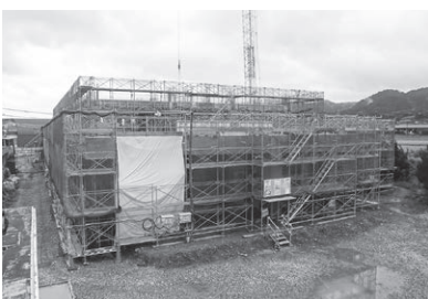
新病院の開院に向け建設が進む
