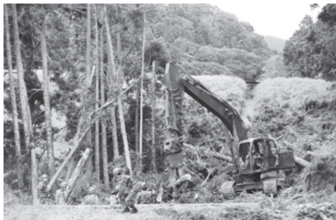
自衛隊員による倒木撤去作業
