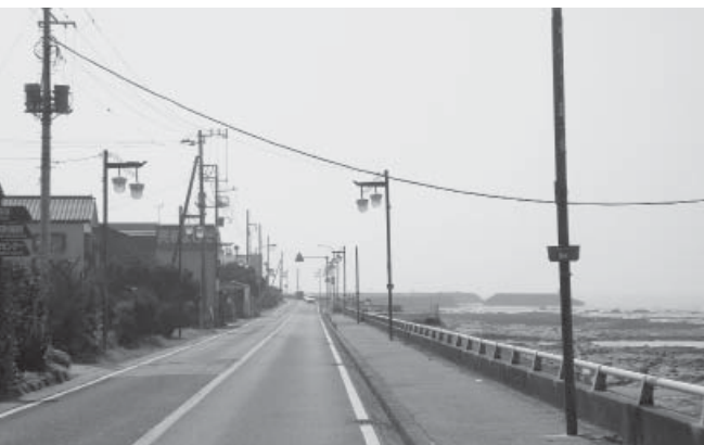
危険なのでアーム部分を取り外した街路灯
