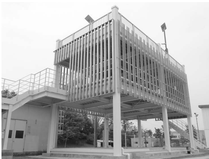
宮城県仙台市の仙台港にある建材メーカー製造所内に従業員や周辺住民の避難のため建設された避難タワー
