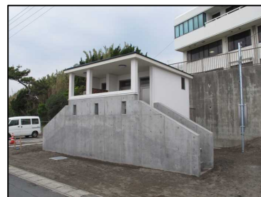
二タ間海岸公衆トイレ
