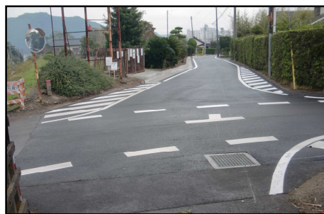
市道整備 (広場地内)
