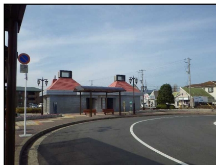
改修された鴨川駅西口トイレ
