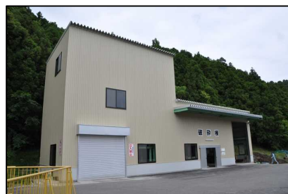
可燃性粗大ごみ破砕処理施設 (鴨川清掃センター)
