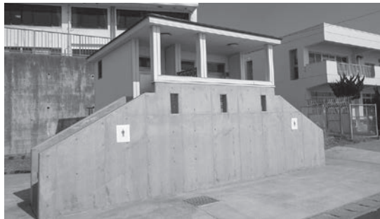
改修される二夕間海岸トイレ(天津)
