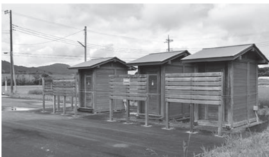
改修される大賀ハストイレ(北小町)
