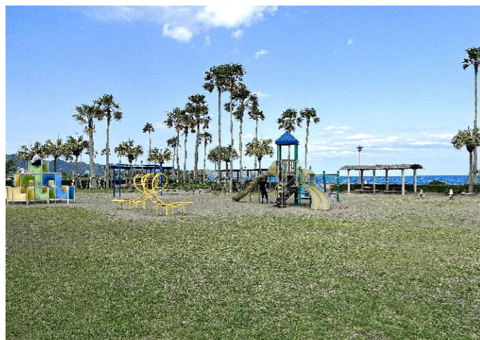
公園遊具が老朽化している
