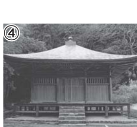
薬王院薬師堂の改修工事への補助金交付 375万円
