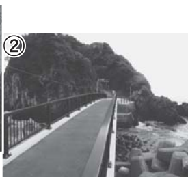
弁天橋改築工事 9,528万5千円
