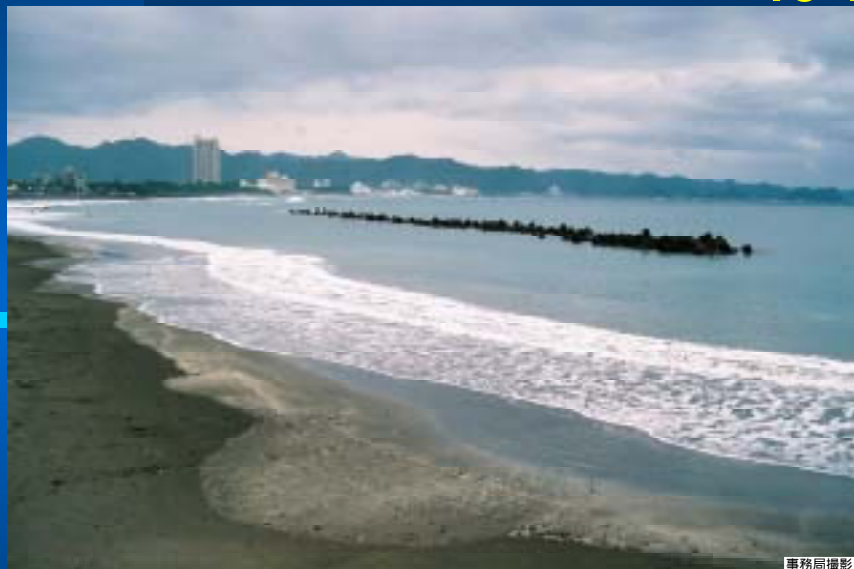
写真?10 前原海岸南端の離岸堤
