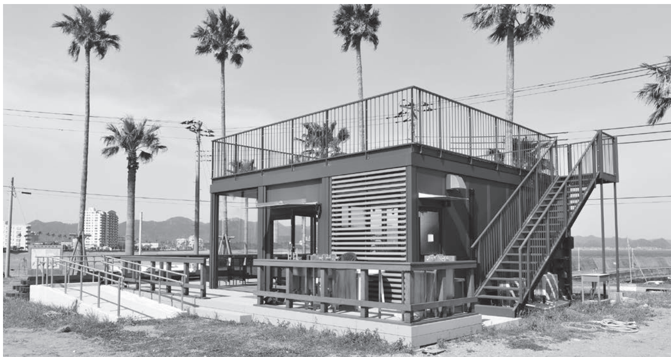
令和5年4月1日に運用開始された、魅力体験広場内の「休憩棟」
