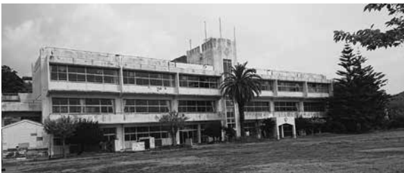
▲旧江見小学校校舎 昭和47年3月竣工、鉄筋コンクリート造3階建て、 延床面積1,838.20㎡
