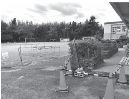
西条小学校に張り巡らされた防護ネット
