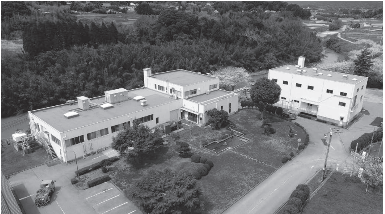
昭和57年に建設され、老朽化している鴨川市衛生センター
