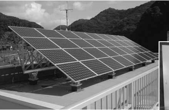
校舎の屋上出力10キロワットの太陽光発電設備を設置
