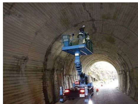
定期点検の状況
