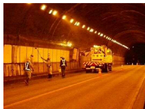
清掃作業の状況
