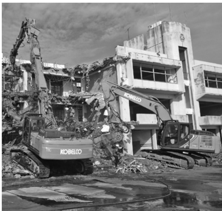
解体中（R6年1月）の旧江見小学校の様子
