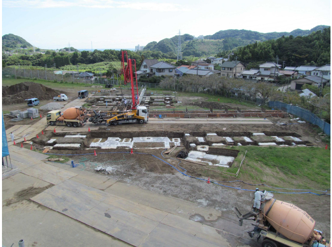
基礎コンクリート打設置状況
