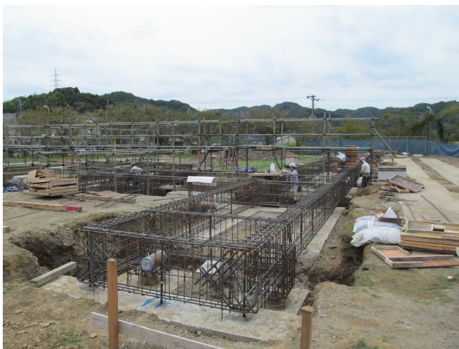
基礎鉄筋組立状況 1工区
