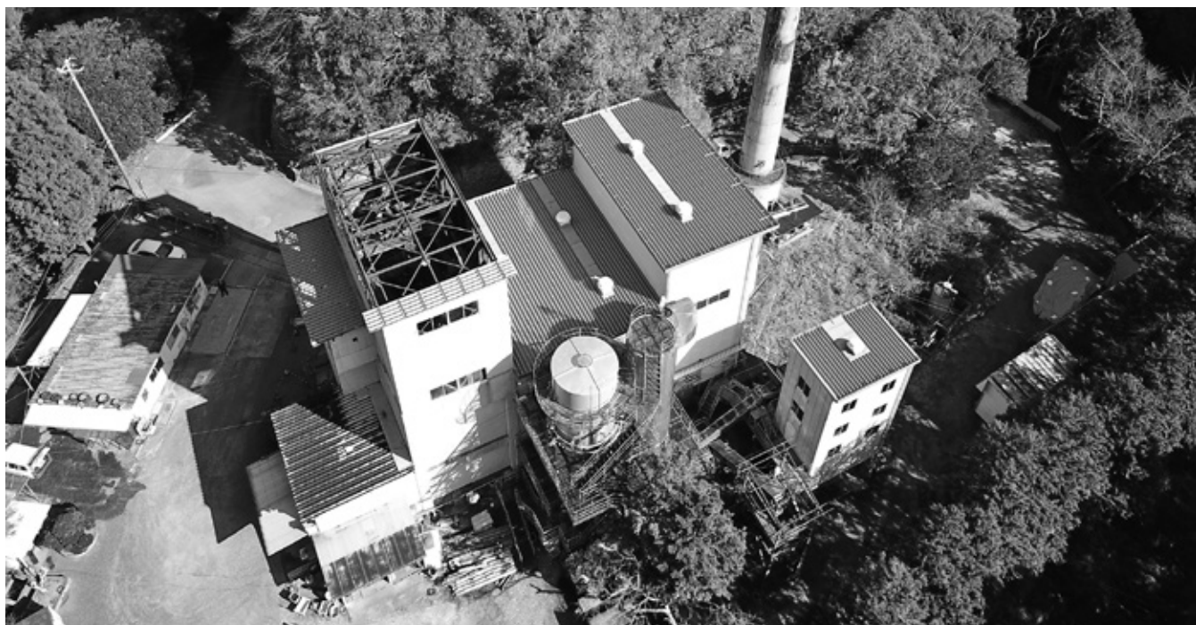
解体中の旧天津小湊清掃センター
