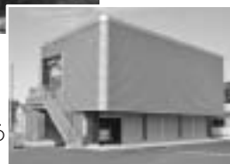
▶津波から設備を守るため附属棟を建築
