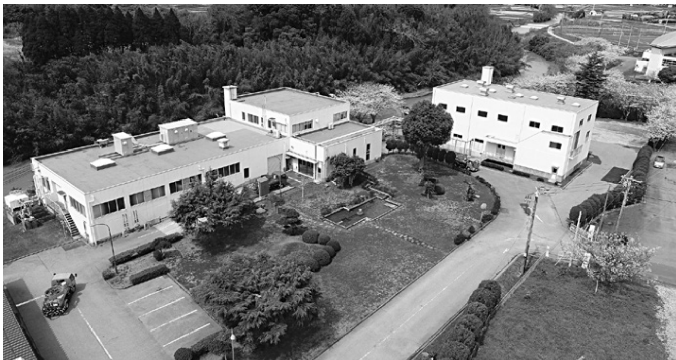
昭和 57 年の竣工から 42 年が経過した衛生センター
