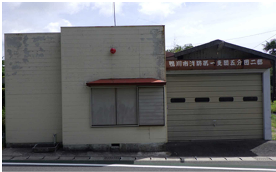
木造平屋建て（車両格納庫一体型）
