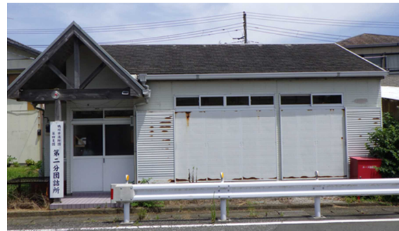
木造平屋建て（車両格納庫別型）
