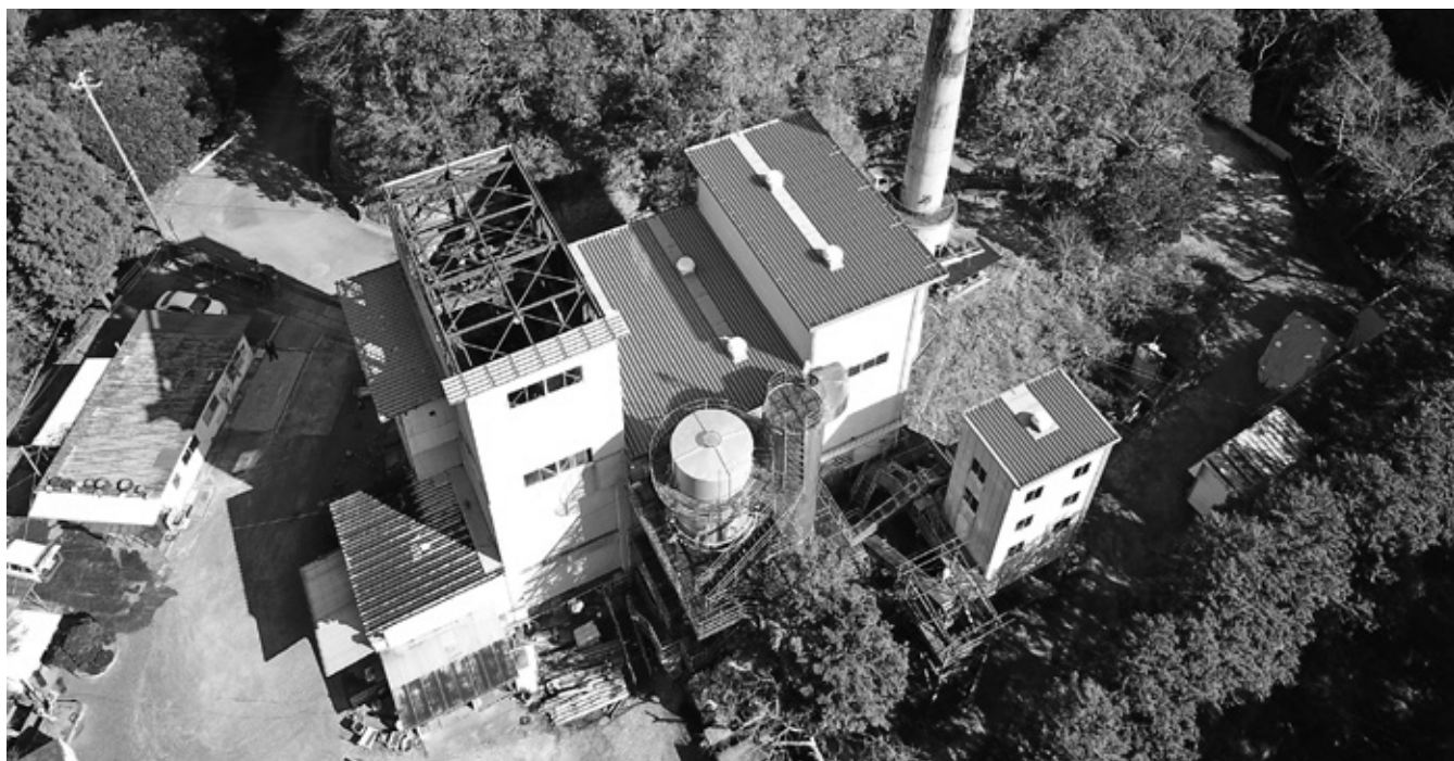
解体中の旧天津小湊清掃センター
