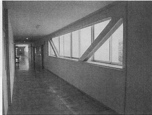
校舎北面ブレース設置
