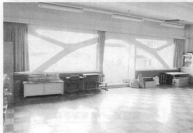
ブレース設置教室内
