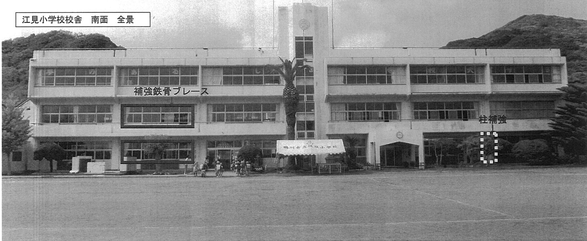
1年教室ブレース設置箇所
