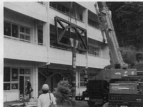
ブレース取付状況
