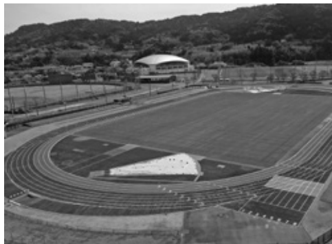
第3種公認改修工事予定の陸上競技場
