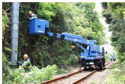
支障樹木の伐採
