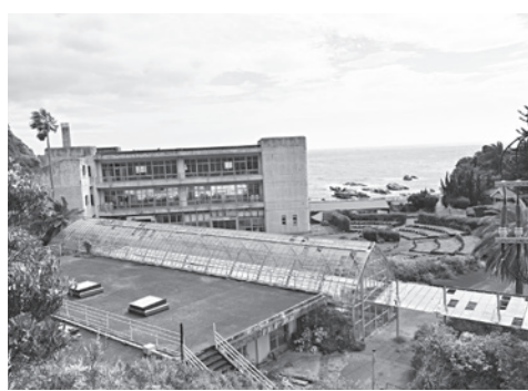
解体工事設計を見直す大海フラワー磯釣りセンター
