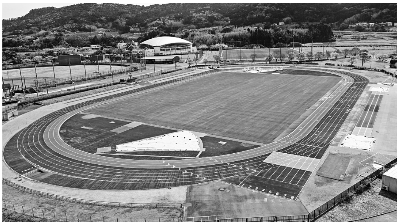
第3種公認改修工事が行われる陸上競技場
