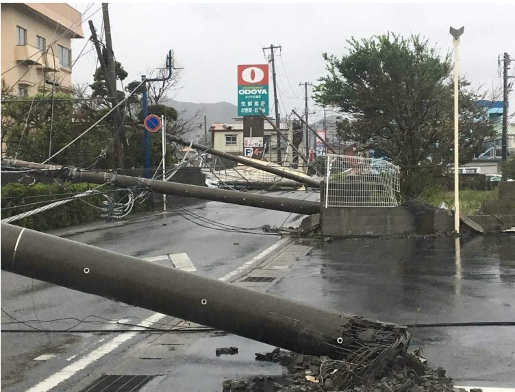
鴨川市広場 鴨川自動車教習所付近
