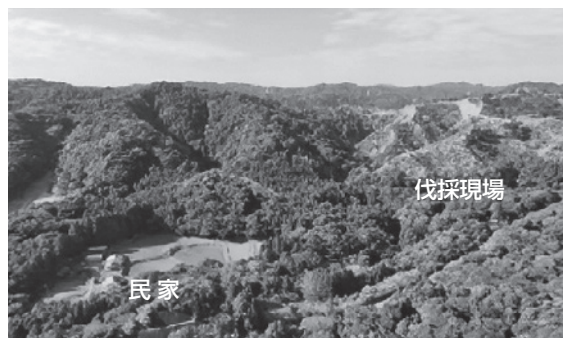
メガソーラー伐採現場と民家
