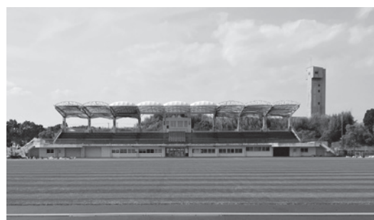
改修されるワタレイスタジアムのスタンド屋根
