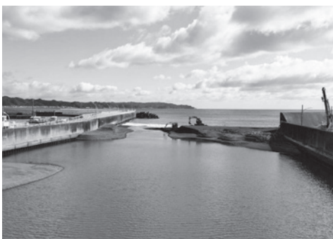
閉塞している加茂川河口部
