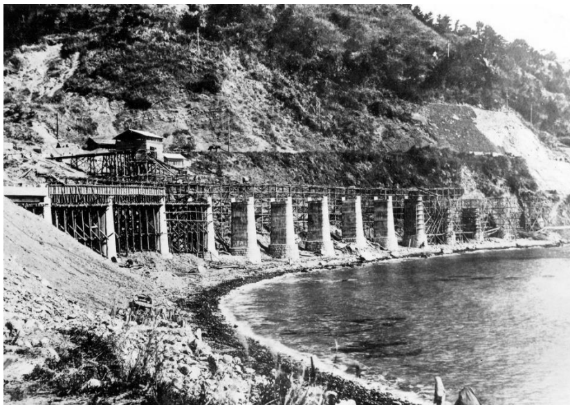
建設中の山生橋梁 (大正11年(1922)ごろ)
