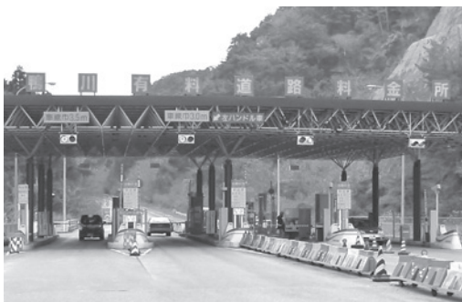
鴨川有料道路料金所
