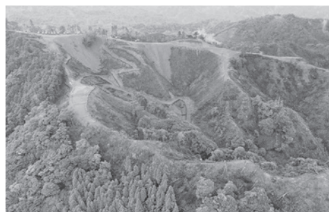
県の指導で残置森林の復旧作業及び防災対策作業中のメガソーラー現場
