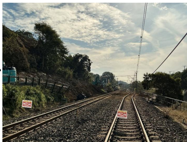
流入した土砂等の撤去後
