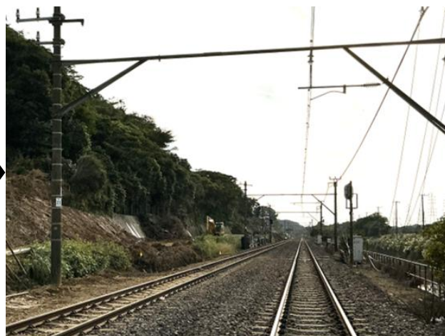
流入した土砂等の撤去後
