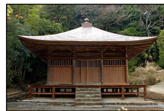
改修後の薬王院薬師堂
