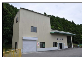
可燃性粗大ごみ破碎処理施設 （鴨川清掃センター）
