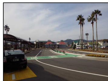
改修した鴨川駅西口ロータリー
