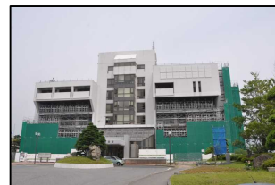
市役所本庁舎耐震補強・大規模改修工事
