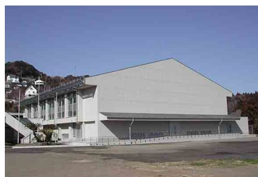
江見中学校屋内運動場を改築
