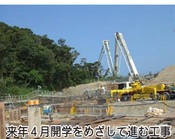
来年4月開学をめざして進む工事
