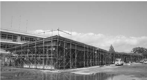
「長狭学園」の校舎建設工事が進んでいます。昨年11月から工事に着手し、現在は、床・天井・内壁の内装工事のほか、照明器具・建具の取り付けや外構工事などを進めています。
