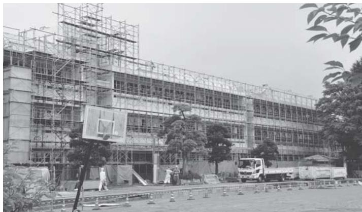
市では、東条小学校の「耐震補強・大規模改修工事」に着手しています。これは、快適な教育環境づくりと大地震に備えた安全・安心な学校施設を確保するため、校舎の耐震補強と老朽化が進む施設の改修を行うものです。工事費は2億7279万円。耐震補強工事では、西側の旧校舎の壁面9か所に鉄骨ブレース(耐震補強材)を設置します。現在、夏休みの期間を利用して、鉄骨ブレースの設置工事を急ピッチで行っています。
