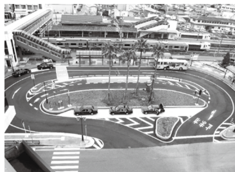
▲鴨川駅西口ロータリーの抜本的な整備を実施
