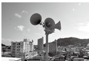
防災行政無線デジタル化改修工事……1億3,185万1千円
