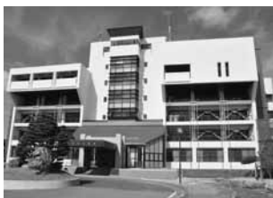
↑庁舎耐震等改修工事 (2か年事業・平成26年度分) ……………15億7,777万2千円
