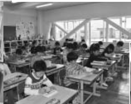
↑鉄骨ブレースで耐震補強された教室
