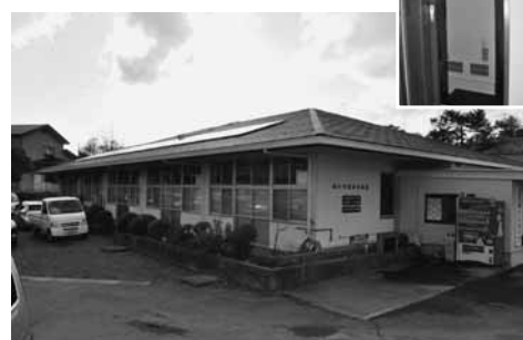
▲福祉作業所の屋根に設置した太陽光発電パネル
