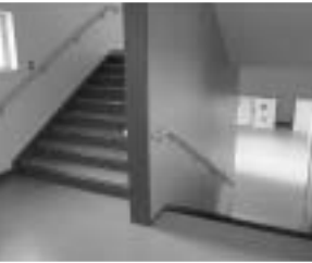
階段は小学生仕様に改修
