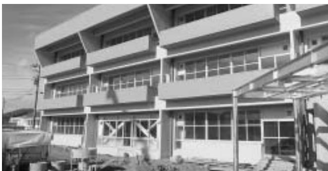
鉄骨プレースにより耐震補強された校舎
